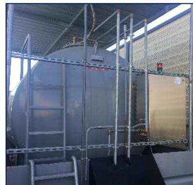
Il Diesel Defender 79 X è un'unità per la filtrazione del gasolio e la separazione acqua, la cui funzione principale è quella di garantire che il carburante stoccato in cisterne o serbatoi per alimentazione motori, venga depurato in modo costante e automatico, per evitare la proliferazione batterica (alghe), la sedimentazione di prodotti derivanti dell'invecchiamento del carburante stesso (morchie) e depositi d'acqua sul fondo provenienti da continui scambi termici.
