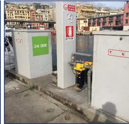
L' Acquasep Diesel Filter è un filtro specificamente progettato per soddisfare i requisiti di pulizia carburante sempre più stringenti, richiesti dai moderni sistemi di iniezione diesel common-rail ad alta pressione.
